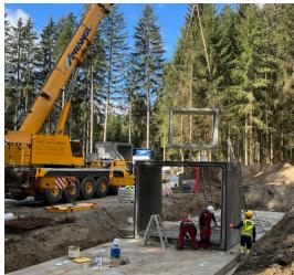
Im Zuge der Errichtung der Wasserversorgungsanlage in der Gemeinde Thaur, wurde auch der Neubau des Trinkswasserspeichers Gruabach realisiert. Hierbei handelt es sich um einen TWS bestehend aus je zwei Wasserkammern mit jeweils 80m³ sowie einer Trocken- bzw. Schieberkammer inkl. Zugangsportal.
