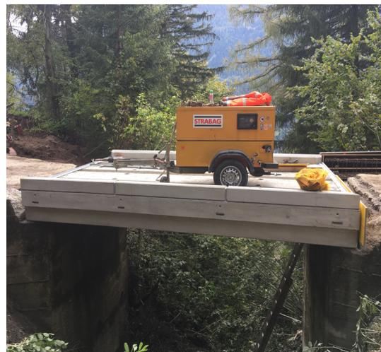
Im Zuge von Instandsetzungsarbeiten im Gemeindegebiet Reißbeck wurden die beiden bestehenden Brückentragwerke der Mühlbachbrücke und der Zwenbergbrücke getauscht.
