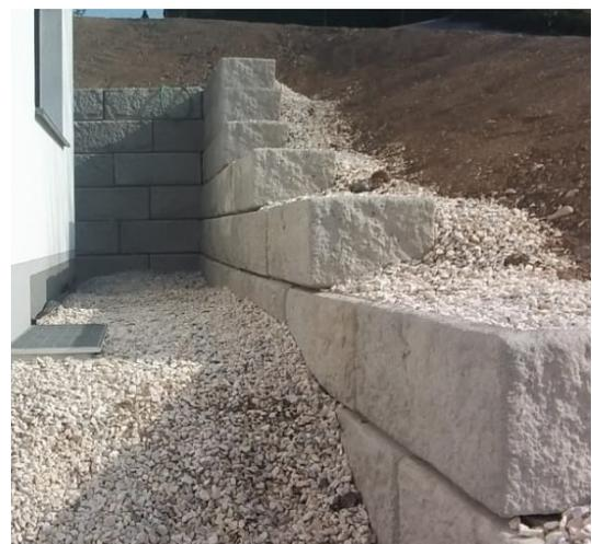
Bei dem Privathaus in Velden wurde zur Absicherung eines Hanges rund um den Neubau ein Stützwandsystem benötigt. Durch das SW-Stützwandsystem wurde hier, aufgrund der bestehenden Regelstatik, eine sichere und optisch ansprechende Hangsicherung erreicht. Durch die modulare Bauweise fügt sich die SW-Stützwand hervorragend in den vorgegebenen Geländeverlauf ein.
