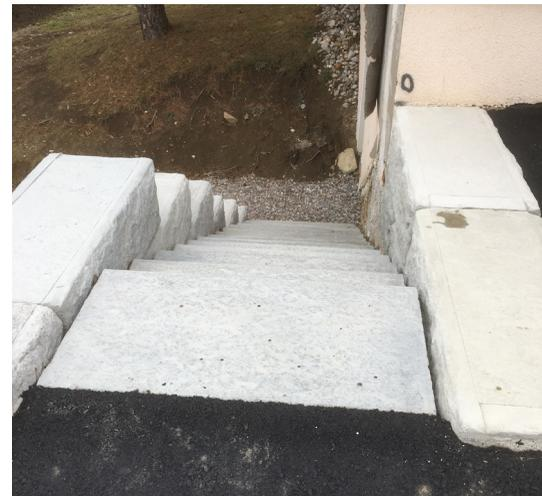
In Oberndorf an der Melk erfolgte die Errichtung einer SW-Stützwand mit Stiegenaufgang und Vollblock-Abschlusssteinen.
