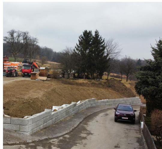
Bei einer Familie in Kirchstetten wurden zwei abgestufte Stützwände als Grundstückseingrenzung und Hangschutz errichtet.
