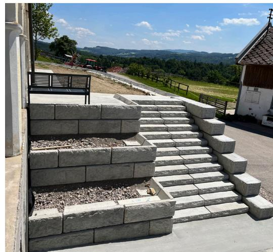
Im Kasten wurden bei einem Einfamilienhaus mehrere Stützwände errichtet. Hier kamen mehrere Ausführungen zu tragen - eine Seite der Stützwand wurde mit einem Stufenaufgang erbaut, die Andere in Terrassenform und geschwungener Zwischenebene. Die obere Stützmauer hat einen abgestuften Abschluss mit Vollsteinen.
