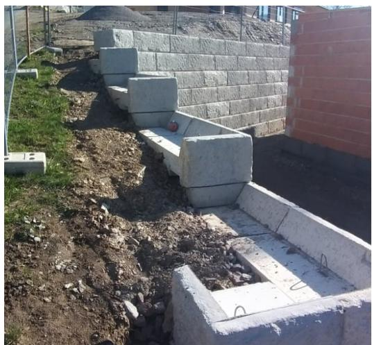
Bei dem Projekt in Dellach im Drautal wurde mittels dem SW-Stützwandsystem eine Hangsicherung auf engstem Raum geschaffen. Durch die geringe Mauerneigung, kombiniert mit statischer Sicherheit, konnte eine platzsparende Lösung gefunden werden, um den Hang hinter dem Haus perfekt abzusichern.
