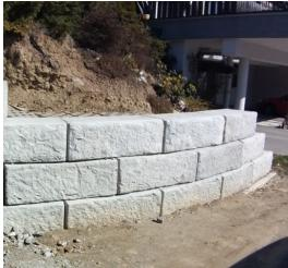
Bei dem Proejkt wurde eine steile Böschung aufgelöst und mittels dem SW-Stützwandsystem zwei Mauern errichtet. Außerdem konnte durch das SW-Stützwandsystem eine Hangstützung und gleichzeitig eine Basis für einen Fussweg geschaffen werden.
