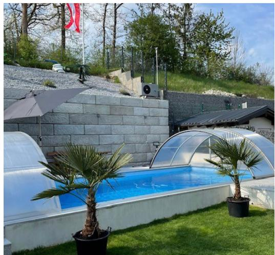
Im Zuge einer Gartenumgestaltung war die Errichtung einer Stützmauer erforderlich und dafür wurde das SW-Stützwandsystem gewählt. Aufgrund der Gegebenheiten war es hier erforderlich möglichst viel Platz zu gewinnen. Des weiteren wurde im Zuge der Arbeiten ein Pool direkt vor der Wand errichtet, welche statisch mit der Mauer abgestimmt werden musste.
