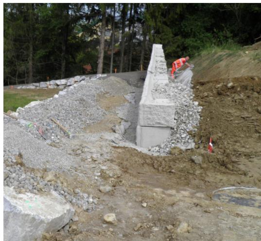
In der Marktgemeinde in St. Margarethen im Burgenland wurde an einem Fußweg entlang ein SW-Stützwandsystem errichtet. Die Ausführung erfolgte teilweise mit Vollsteinen als Abschluss.
