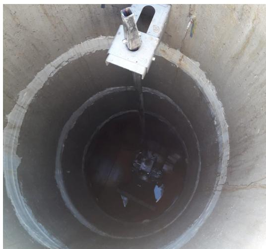
Für die Entwässerung der Parkflächen von der A2 Südbahn Raststation Witzelsberg wurde eine Gewässerschutzanlage errichtet. Die Oberflächenwässer vom Parkplatz der Raststation werden über eine technische Gewässerschutzanlage bestehend aus Einlaufbauwerk, Retentions- und Absetzbecken (Schlammsammelraum) sowie nachgeschaltetem Filterbecken mit technischen Filtermaterial und Ablaufbauwerk gedrosselt in einen Vorfluter abgeleitet.
