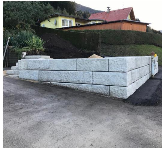
Der alte Zufahrtbereich wurde entfernt und die leichte Hangneigung eingeebnet um für die vorgesehene Poolfläche mehr Platz zu gewinnen. Auch Stufenplatten für den direkten Zugang wurden verwendet.
