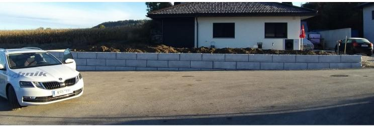
Das SW-Stützwandsystem wurde hier als Gartenmauer und als Abgrenzung zur Straße errichtet. Zusätzlich wurden die Oberfläche in Steineoptik mittels einer Nanoversiegelung beschichtet.
