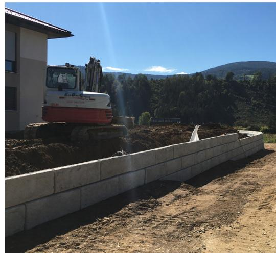
Hier wurde eine alter Hangbewuchs entfernt und durch das SW-Stützwandsystem für noch mehr Platzgewinn perfekt eingesetzt. Die Ausführung erfolgte kombiniert in Rund- und Eckausbildung, sowie teilweise mit Vollsteinen als Abschluss für die Errichtung eines Carports.
