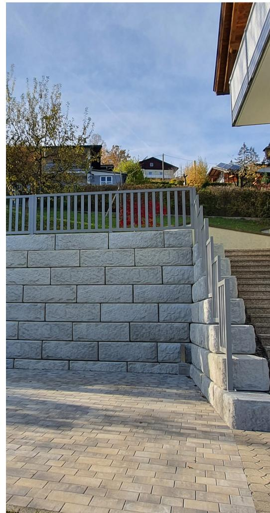
Das SW-Stützwandsystem wurde hier zur bestmöglichen Platzgewinnung und Erweiterung des Einfahrtsbereiches inkl. einem integrierten Treppenaufgang eingesetzt.
