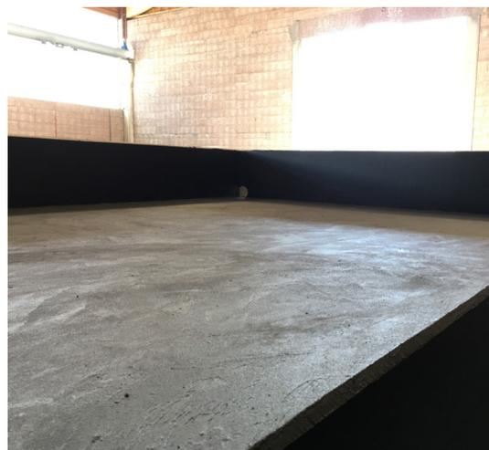
Für eine Drucksteigerungsanlage wurde eine Einhausung in rechteckiger Bauweise inkl. Edelstahlleingangstür und Abdeckplatte mit Attika produziert.
