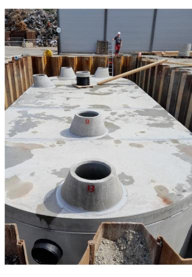
Errichtung einer Großabscheideanlage mit einer Nenngröße von 400 l/s für die Entwässerung von befestigten Freiflächen bei der Firma Scholz Rohstoffhandel in Wien.
