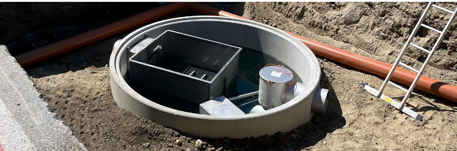
Für die Erweiterung eines Lagerplatzes auf dem Gelände der Borealis in Linz wurde ein Leichtflüssigkeitsabscheider benötigt. Hier kam unser Verkehrsflächensicherungsschacht zum Einsatz.
