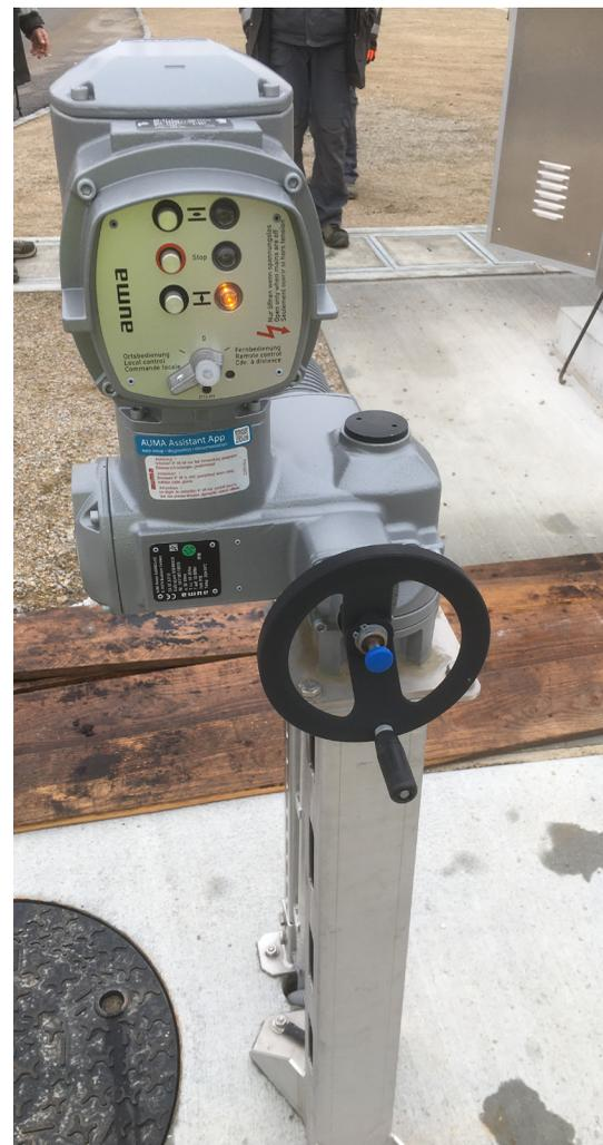
Bei dem Projekt wurde eine Trafograben-Entwässerung beim Umspannwerk Neusiedl an der Zaya errichtet. Die anfallenden Oberflächenwässer aus den Trafograben werden über einen Schieberschacht mit automatischen Schieber, nachfolgenden Mineralölabscheider und anschließendem Pumpwerk nach vorhergehender Kontrolle durch das Betriebspersonal durch eine automatische Reinigungsanlage entwässert.
