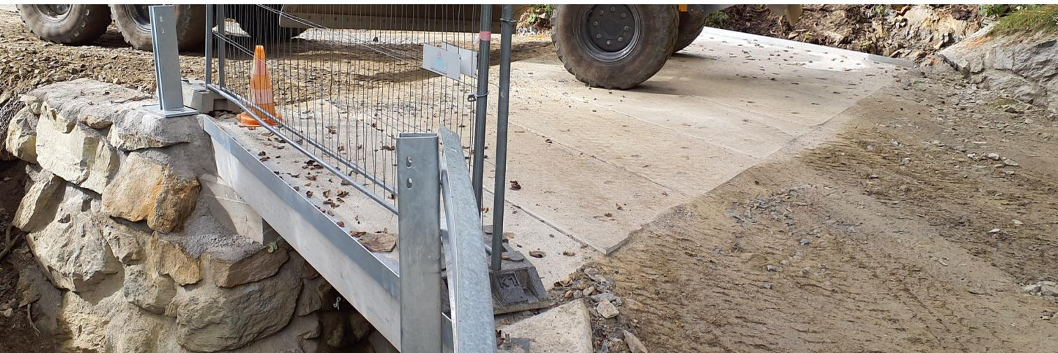
Die Brücke befindet sich in der Gemeinde Hopfgarten in Deferegggen. Die Fertigteil-Brückenplatten wurden auf die bestehenden Widerlager mittels Autokran versetzt. Unsere Brückentragwerke aus Betonfertigteilen ermöglichen sehr kurze Bauzeiten. Die Tragwerksabmessungen betragen: Länge: 3,45 m, Breite 7,00 m. Die Tragfähigkeit der Brücke beträgt 44 Tonnen.
