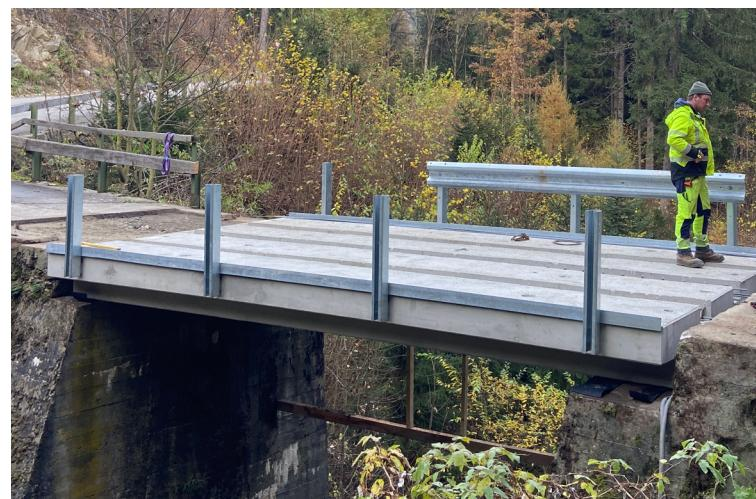
Die alte Zischgerbrücke in der Osttiroler Gemeinde Schlaiten, die den Göriachbach überspannt, wurde durch eine Stahlbeton-Konstruktion ersetzt. Dabei handelt es sich um vier Stück T-Profile mit einer Länge von 682 cm, einer Breite von 150 cm sowie einer Höhe von 55 cm. Die Teile wiegen ca. 7200 kg pro Stück. Die Brückenkonstruktion weist eine Tragfähigkeit von 44 t auf.
