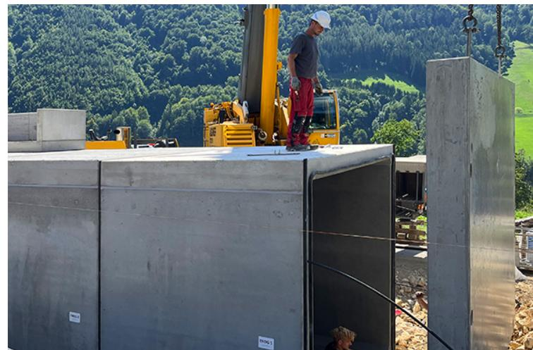
Für die Gemeinde Reichraming wurde im Ortsteil Oberau ein neuer Trinkwasserhochbehälter mit einer Trockenkammer und zwei Wasserkammern mit jeweils 40 m<sup>3</sup> errichtet. Zur Ausführung kam ein SW-Trinkwasserspeicher in Beton, als Spannbeton system in modularer Bauweise gefertigt.
