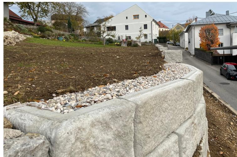
Mit dem SW-Stützwandsystem wurde die Böschung eines Einfamilienhauses in Sierning als abgestufte Stützmauer ausgeführt, wodurch eine Vergrößerung der ebenen Gartenfläche realisiert werden konnte.
