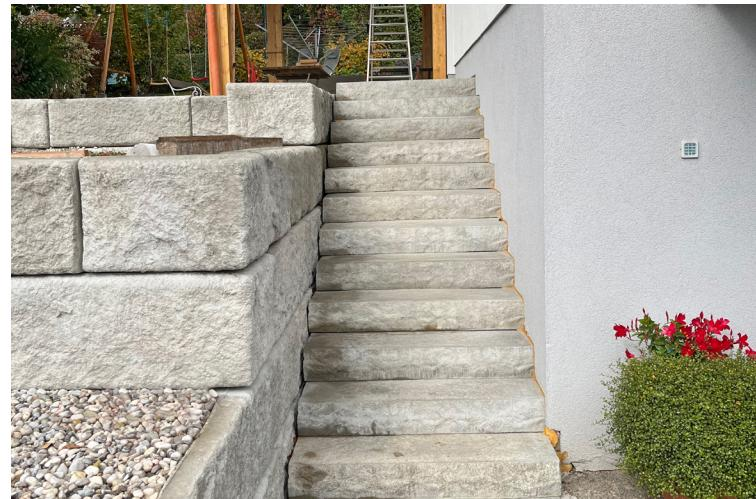
Bei einem Einfamilienhaus in Ried im Traunkreis wurde das SW-Stützwandsystem als terrassierte Stützmauer und mit Treppe ausgeführt.
