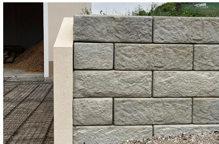
Das SW-Stützwandsystem kam zur Absicherung einer Böschung bei der Zufahrt zu einer Halle in Kematen zum Einsatz.
