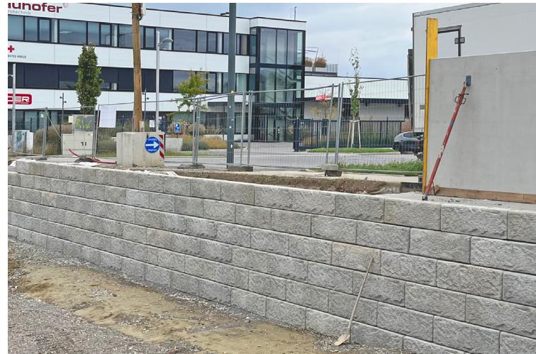
Beim Neubau der Firmenzentrale von Dennree Naturkost in Wien wurde das SW-Stützwandsystem als Stützmauer verbaut.
