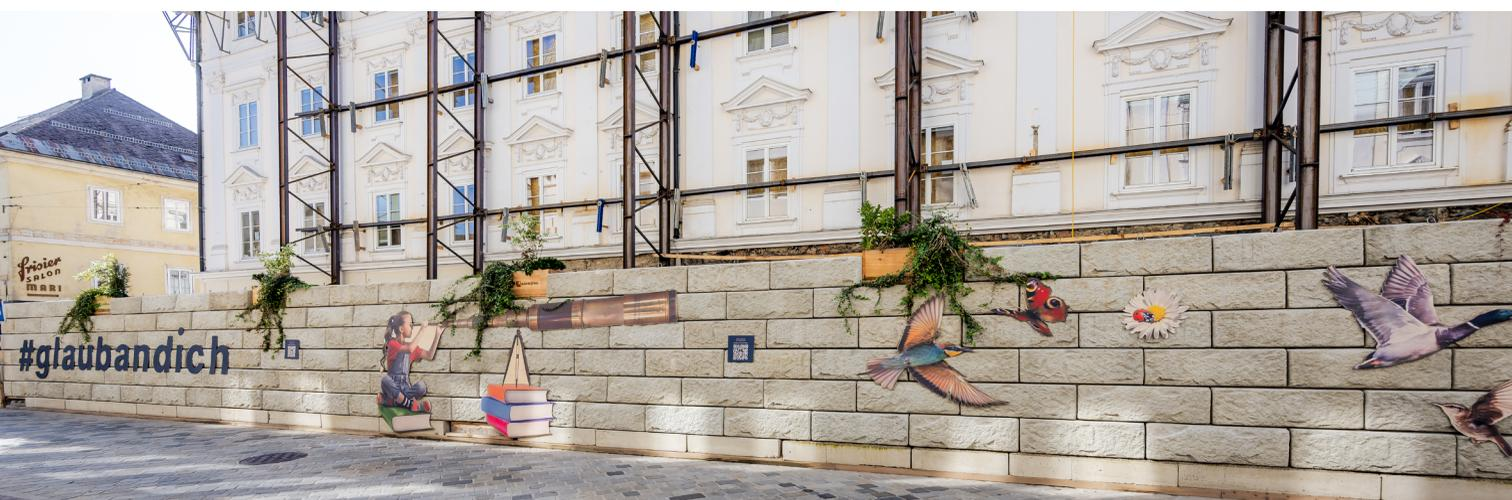
Das SW-Stützwandsystem erfüllt bei diesem Bauvorhaben zwei Funktionen. Einerseits dient das Gewicht der Mauer zur Stabilisierung des Baugerüsts, andererseits konnte durch die Optik der Steine ein Sichtschutz geschaffen werden, der sich hervorragend in das Stadtbild einfügt. Durch das modulare System konnte die Mauer in kürzester Zeit aufgestellt werden, wodurch sich die Behinderung des Stadtverkehrs minimieren ließ.
