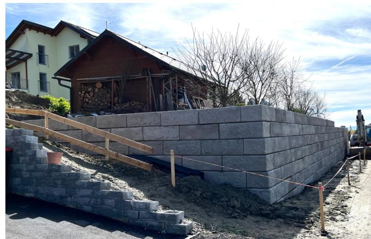
Errichtung einer 2,8 m hohen Stützwand als Abstützung des Gartens eines Familienhauses in Walding, mit einer Außenecke und einer Rundung am Mauerende. Zusätzlich wird für die Gartenbewässerung eine 2-Becken Betonzisterne mit je 15m<sup>3</sup> Inhalt eingebaut.
