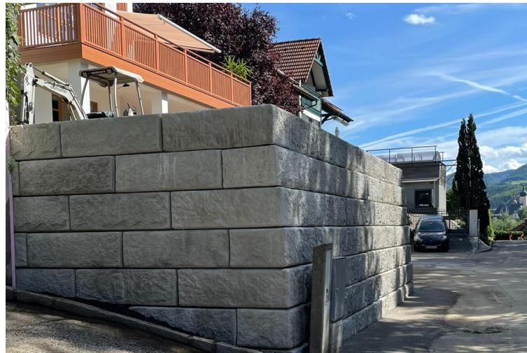
Bei einem Privathaus in Waidhofen an der Ybbs wurde zur Vergrößerung des Terrassenbereiches eine SW-Stützwand mit drei Außenecken und einem Innenbogen innerhalb weniger Tage realisiert.
