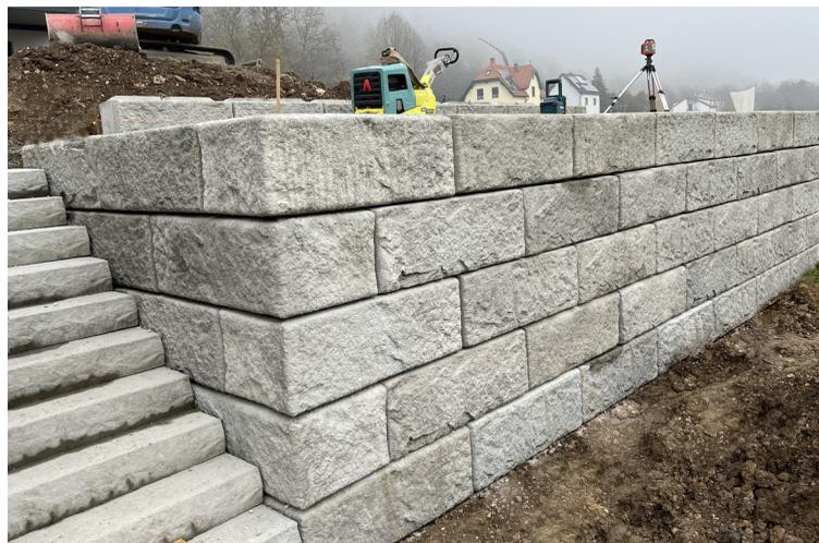
In Winzendorf, Niederösterreich, wurden bei der Familie Novak ein Gerätehaus sowie ein Pool und eine Fläche für Hochbeete neu gestaltet und errichtet. Für die Stützwände und den erforderlichen Stufenaufgang kam das SW-Stützwallsystem zur Anwendung. Sämtliche Wände wurden exakt auf 0° versetzt, und als Abschlusssteine wurde der neue Zaunsockelstein verwendet, auf dem direkt die Absturzsicherung montiert werden konnte.
