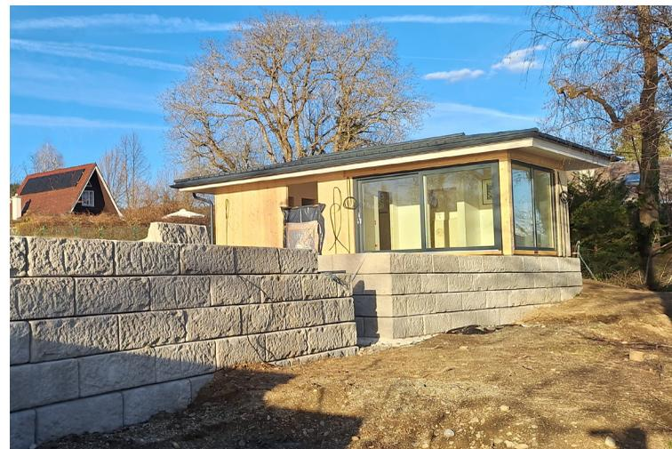
Mit dem SW-Stützwandsystem wurde eine steile Böschung am Ufer des Wörthersees befestigt. Dadurch konnte eine ebene Fläche für das Badehaus sowie eine großzügige Liegefläche geschaffen werden. Der Zugang zur unteren Ebene sowie der Zugang zum See erfolgt über die SW-Stufenplatten.
