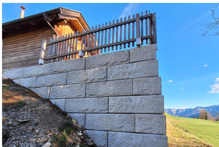
Bei diesem Privathaus in Fresach wurde eine pflegeintensive und veraltete Krainerwand durch eine ästhetische und funktionelle SW-Stützwand ersetzt. Gleichzeitig konnte durch eine Erhöhung der Mauer eine Begradigung der oben liegenden Gartenfläche erreicht werden.
