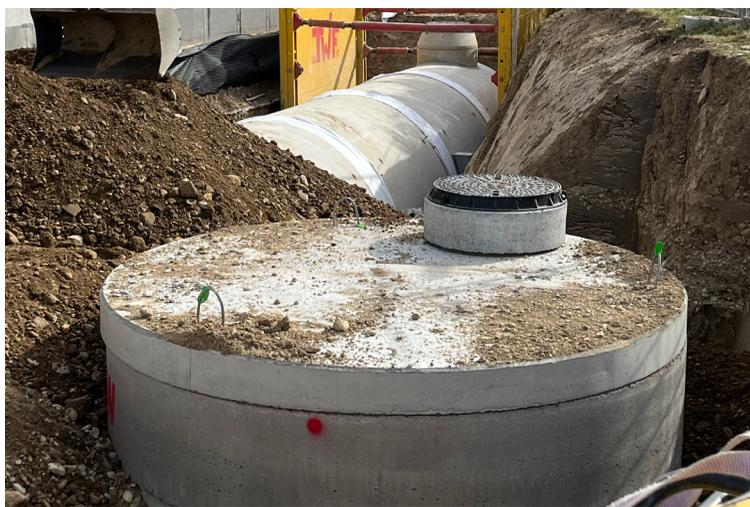
Die befestigten Freiflächen des Gesundheitszentrums II in St. Pölten werden über Vorschlammfänge (Absetzbecken) sowie einen Sickertunnel mit technischem Filter entwässert und die Dachflächen werden über angeordnete Wartungs- und Absetzschächte entwässert.
