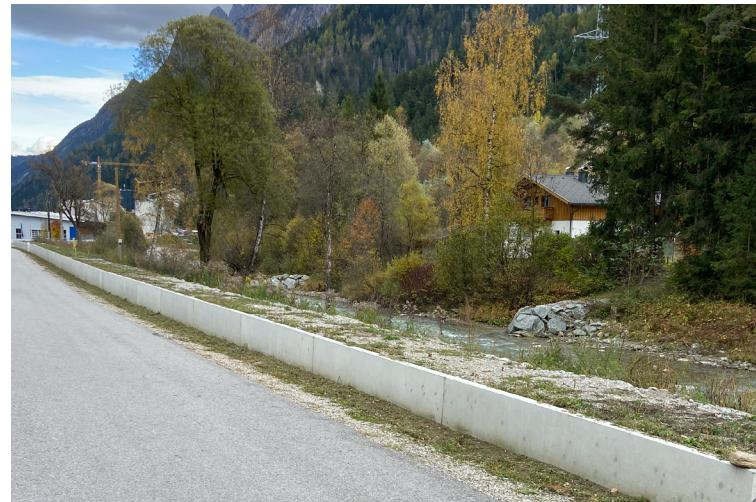
In Assling im Bezirk Lienz wurden SW-Betonfertigteile als Hochwasserschutz entlang der Drau verbaut.
