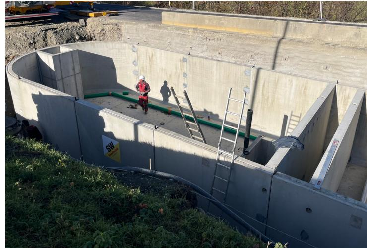
Im Zuge der Sanierung der A 12 Inntalautobahn wurden insgesamt vier Stück Gewässerschutzanlagen in modularer Bauweise im Bereich Hall West bis Innsbruck Ost eingebaut.
