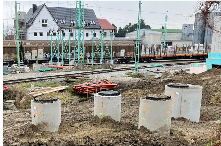
Für die Oberflächenentwässerung wurde im Zuge der Attraktivierung des Bahnhofes in Wulkaprodersdorf ein Verkehrsflächensicherungsschacht in modularer Bauweise für die Vorreinigung des Oberflächenwassers eingebaut.
