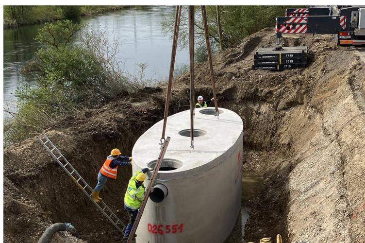
Entwässerung der Zufahrtsstraße zur VOEST im Abschnitt Lunzerstrasse. Über mehrere Einlaufschächte wird das Wasser des Strassenbereiches über zwei Verkehrsflächensicherungsschächte gereinigt. Anschließend wird das vorgereinigte Oberflächenwasser in den Jauckerbach bzw. die Traun abgeleitet.
