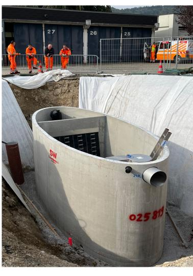
Bei der Autobahnmeisterei Alland (ASFINAG) wird ein Teil der befestigten Fläche über einen neuen Verkehrsflächensicherungsschacht der Type SW-VERKEHRSFL. VFS 145-18,8 EN entwässert. Für die adaptierte LKW Waschhalle mit einer zusätzlichen Unterbodenreinigungsanlage wurde ein neuer Vorschlammfang mit großer Montageöffnung - ein Becken mit einem Innendurchmesser von 300 cm - sowie eine Mineralölabscheideanlage SW-EURO-SEDIRAT SMA 20-7,4 errichtet.
