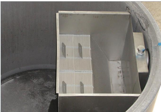
VFS bis Nenngröße 65 mit Schrägklärkästen und integrierter Probenahmemöglichkeit
