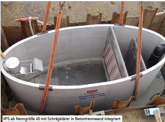
VFS ab Nenngröße 65 mit Schrägklärer in Betontrennwand integriert
