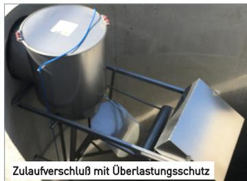
Zulaufverschluß mit Überlastungsschutz
