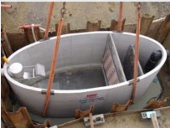
VFS ab NG65 wird der Schrägklärer vertikal ausgeführt
