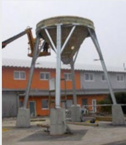
Versetzen und Montage eines Salzsilos
