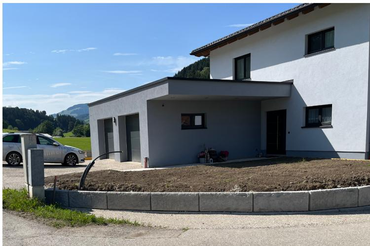
Bei der Familie Schachermayer in Ertl wurde eine Grundstückseinfriedung errichtet. Aufgrund der schnellen Bauzeit und optischen Formgebung wurde das SW-Stützwandsystem gewählt. Die mögliche Erweiterung der Stützwand war ebenfalls ein Aspekt und wurde auch bereits umgesetzt.
