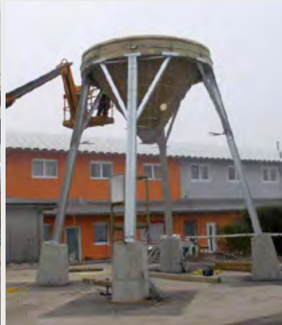
Versetzen und Montage eines Salzsilos
